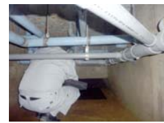
地下ピット既存配管状況
