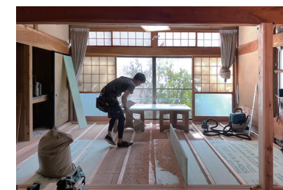
上：工事前の写真。雨漏りで畳が腐ってしまっている 下：床材の張り替え
