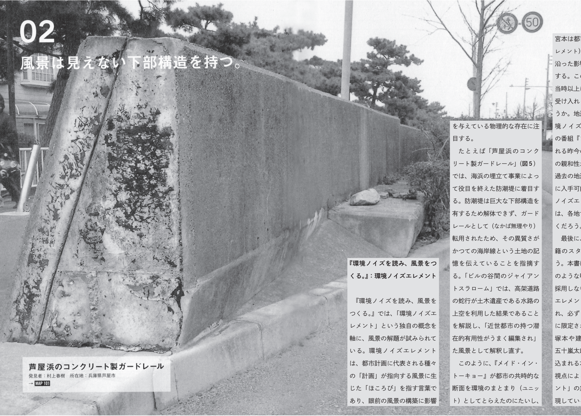
図5 芦屋浜のコンクリート製ガードレール、『環境ノイズを読み、風景をつくる。』より
