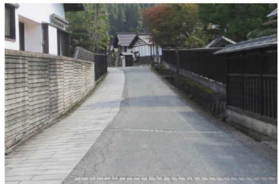
図11 整備された街路
