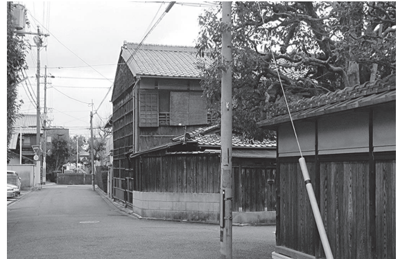
Fig. 22 既存建物の近景
