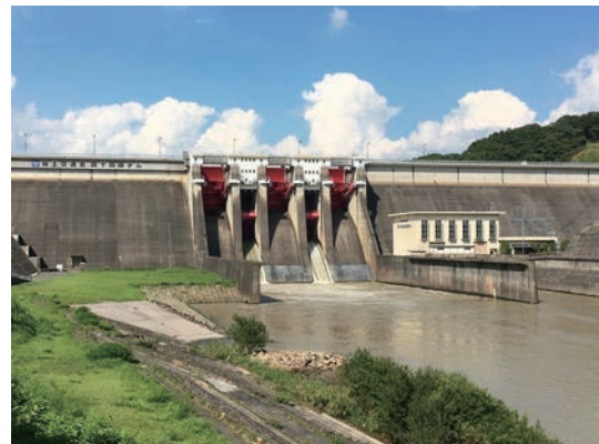
図30 ダムと水力発電(四十四田ダム)
