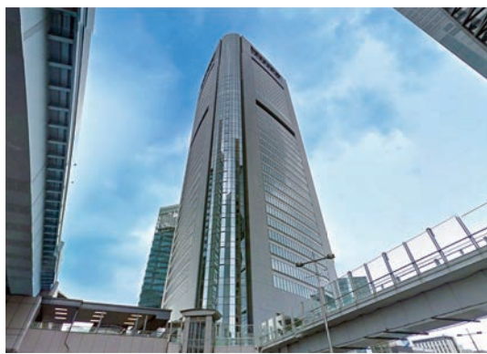
図1 パークホテル東京が入る汐留メディアタワー（東京・汐留）
