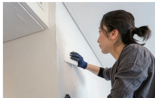
図6 クロスの目地埋め作業の様子
